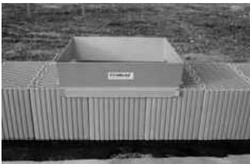
Pierwsza warstwa bloczków przygotowana do zasypu
